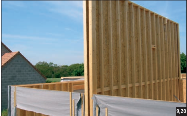
Fig. 9,20 Ces étrésoillons diminuent le risque de flambement et permettent l'agrafage des panneaux lorsque la longueur des montants est supérieure à 2,50 m ou l'accrochage d'éléments lourds (meubles de cuisines, appareils sanitaires suspendus...) dans la paroi.
