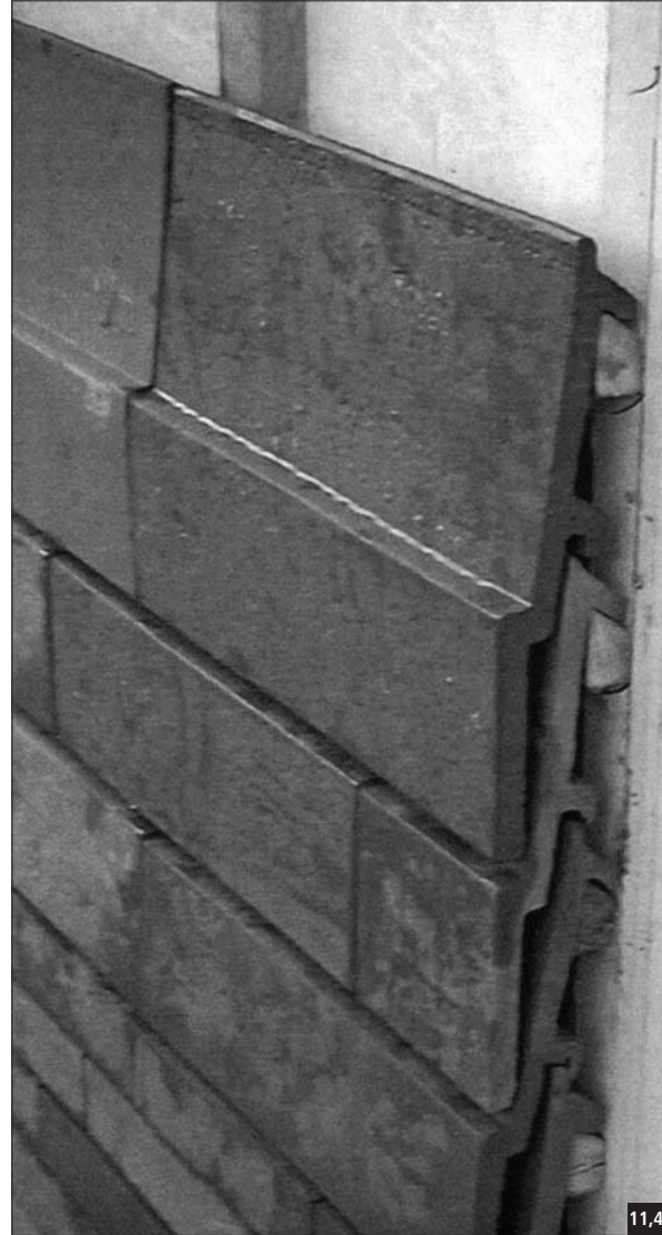
Fig. 11,41 Bardeaux de terre cuite à double accrochage.
