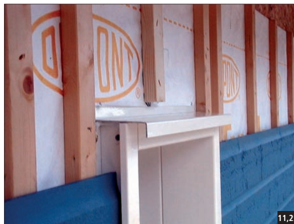
Fig. 11,24 Exemple de raccordement horizontal avec une bavette.
