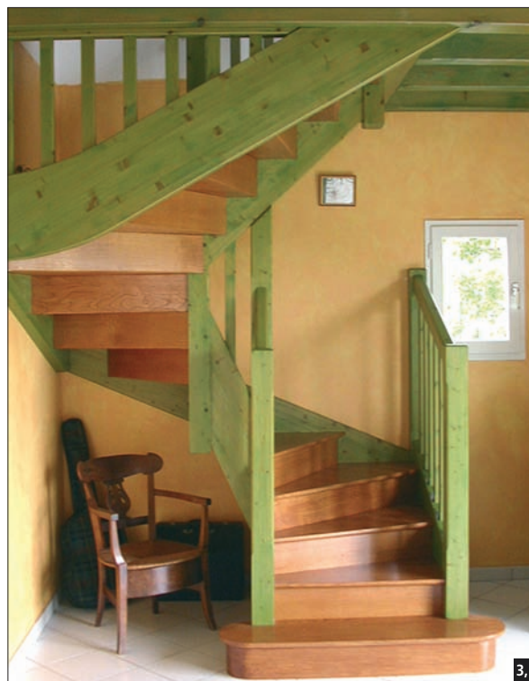
Fig. 3,5 Escalier avec quartier tournant haut et bas.
